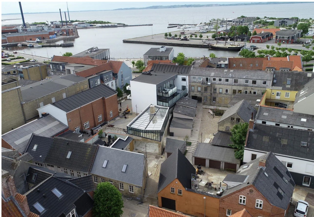
Foto: Thisted Passage, Thisted Kommune - Thisted Passage er etableret som en ny forbindelse gennem Thisted bymidte, der skaber sammenhæng mellem byens handlegader, torve og byrum. Forbindelsen gør det nemmere og mere inviterende at bevæge sig til fods gennem midtbyen og bidrager til et mere tilgængeligt og aktivt byliv.
